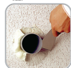
4. Una vez fraguada, cortar el exceso de espuma con un cuchillo o sierra fina.
